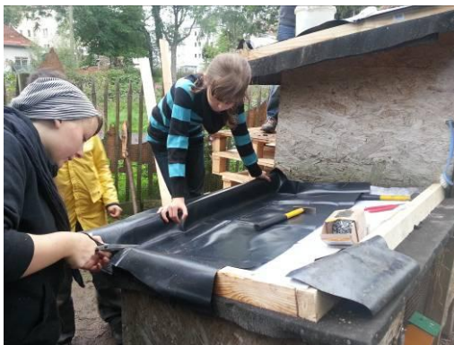
Teichfolie aufbringen und mit Vlies abdecken und Regenablauf einbauen
