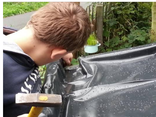
Teichfolie aufbringen und mit Vlies abdecken und Regenablauf einbauen
