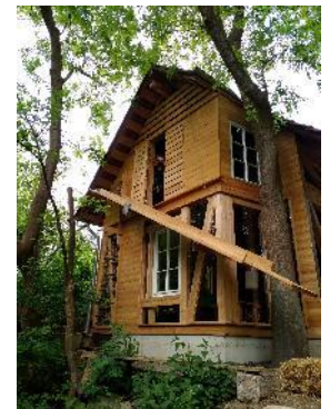
Links die neue Treppe. Rechts die kippbare Rampe: hier kann man einen Ballen aus der Scheune direkt in eine Schubkarre rutschen lassen.
